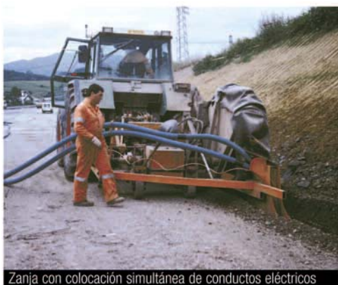
Zanja con colocación simultánea de conductos eléctricos
