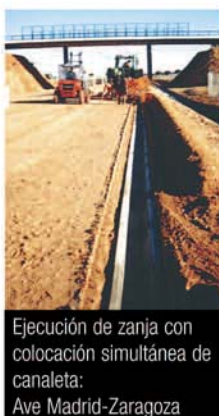
Zanja con colocación simultánea de conductos eléctricos
